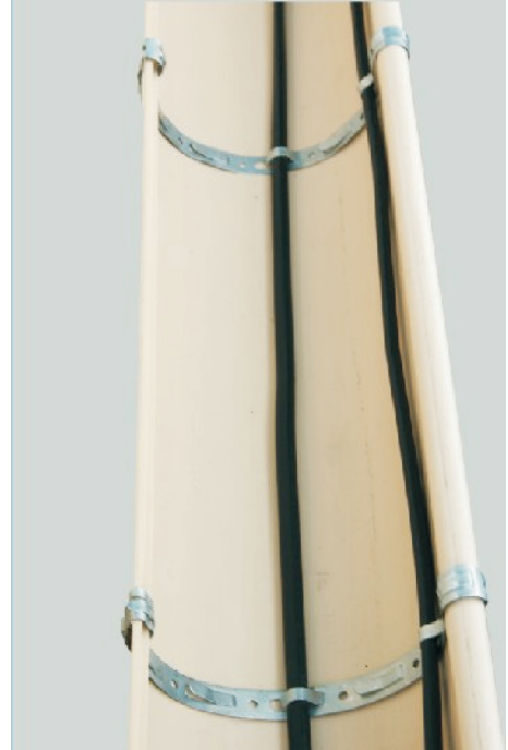
Grejni kabl instaliran u oluku uz pomoć ELEKTRATMS trake
